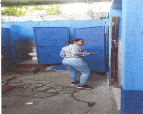
Foto 3: Sustitución de puertas de metal
