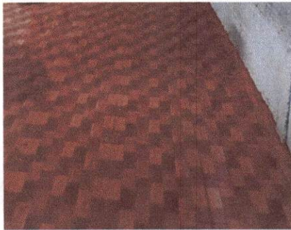
Foto 3: Cambio de Piso Ceramico Aula 2
