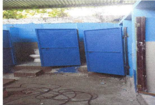
Foto 6: Colacion de Puerta De Metal Aula de Segundo Nivel
