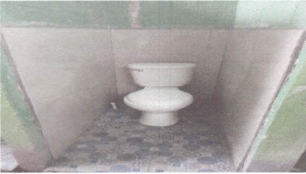
Foto1: Cambio de inodoros
