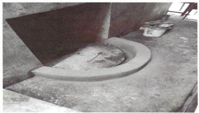
Foto 2: Sustitución de la bomba de agua
