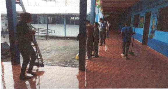
Foto1: Cambio de Piso Ceramico Corredor
