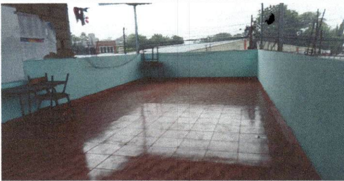
Foto 5: Colocación de Piso Ceramico Aula Segundo Nivel
