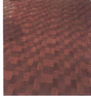
Foto 2: Cambio de Piso Ceramico Aula 1
